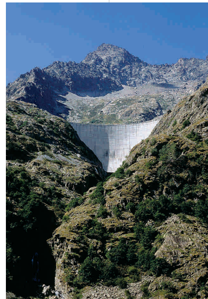
Le barrage du Chiotas
